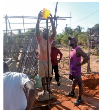
深井戸掘削作業
