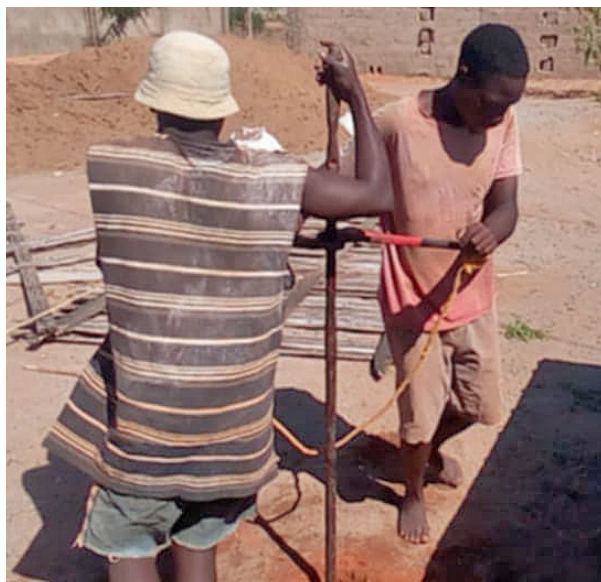
陽気に歌いながら深井戸掘削作業
